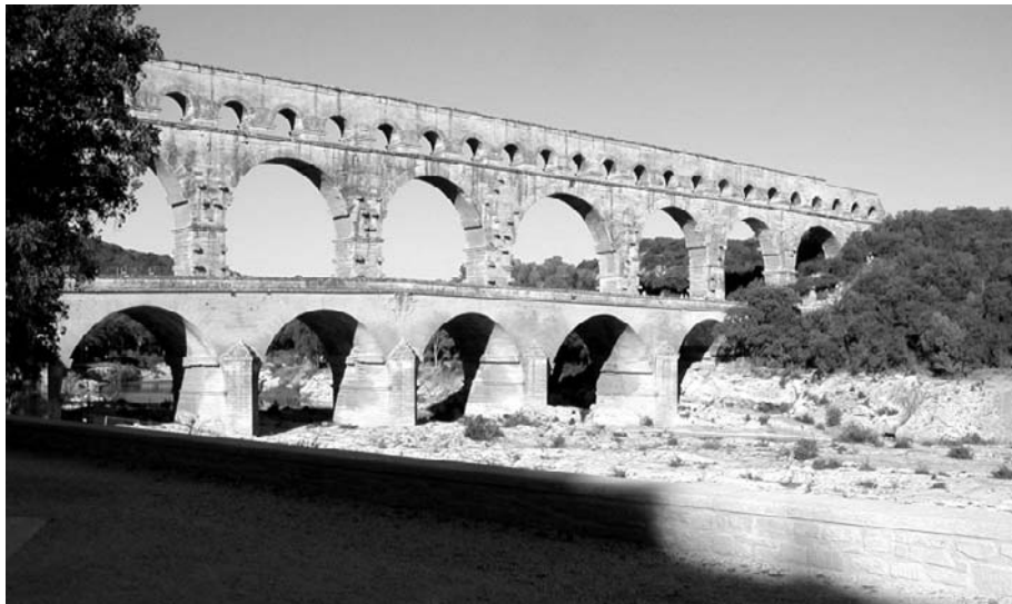
Гардский мост (Франция) — трехъярусная конструкция: мост по нижнему уровню, акведук по верхнему уровню, снабжавший водой из источников город Ним. Построен римлянами в I в.
