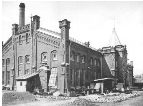
Москва. Первая станция перекачки городской канализационной системы, охватившей не только центр, но и Сокольники. Строительство завершено в 1900 г.
