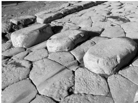
Помпеи (Италия). Пешеходный переход через главную улицу с одного тротуара, замощенного мозаикой из обломков керамических плиток, на другой. Не позднее I в., когда Везувий убил город.
